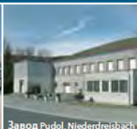
Завод Pudol, Niederdreisbach
